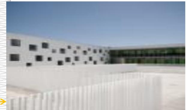
**Acceso;** El cerramiento norte y poniente se ejecuta en base a una celosía metálica vertical de perfiles de acero que protege los recintos semi-exteriores de la radiación directa del sol.
